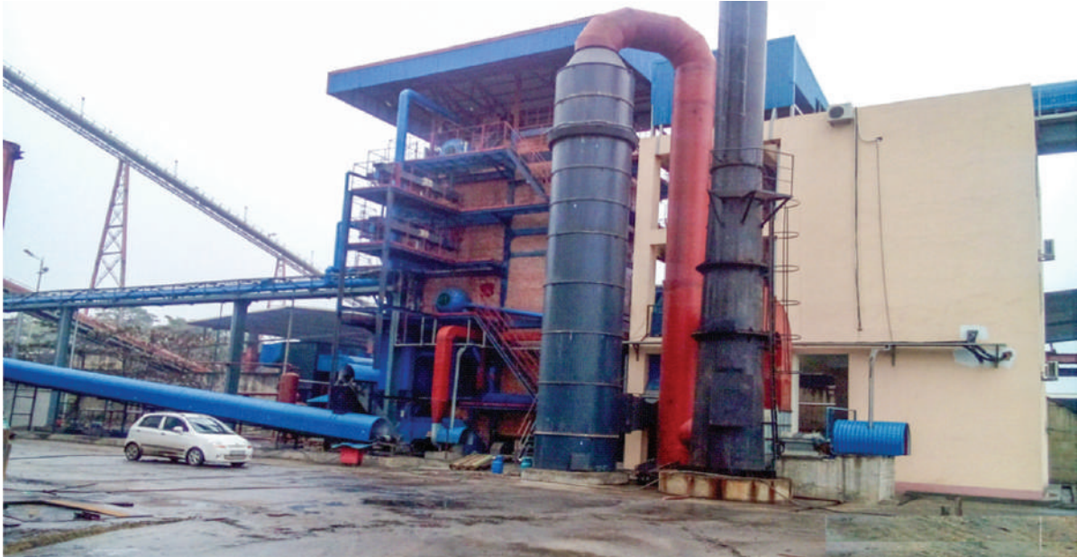
07/ CÔNG TRÌNH THI CÔNG LẮP ĐẶT HỆ THỐNG LÒ HƠI CÔNG SUẤT 20 T/H TỔNG CÔNG TY GIẤY VIỆT NAM – PHÚ THỌ
