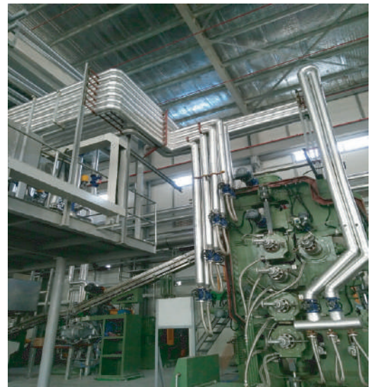
14/ DỰ ÁN: THIẾT KẾ, THI CÔNG, LẮP ĐẶT HỆ THỐNG ĐƯỜNG ỐNG CẤP HƠI - NHÀ MÁY TOPT TEXTILES
