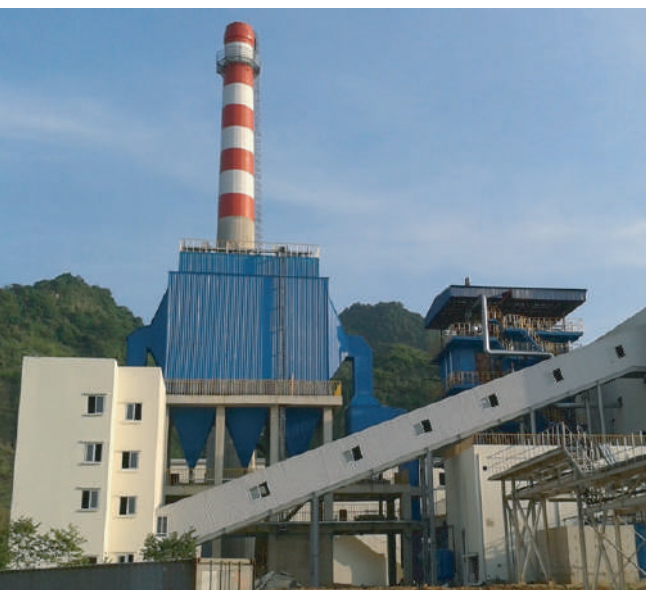
04/ CÔNG TRÌNH NỒI HƠI TẦNG SÔI ĐỐT THAN 50 TẤN/GIỜ NHÀ MÁY GIẤY AN HOÀ – TUYÊN QUANG
