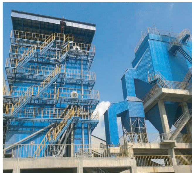
04/ CÔNG TRÌNH NỒI HƠI TẦNG SÔI ĐỐT THAN 50 TẤN/GIỜ NHÀ MÁY GIẤY AN HOÀ – TUYÊN QUANG
