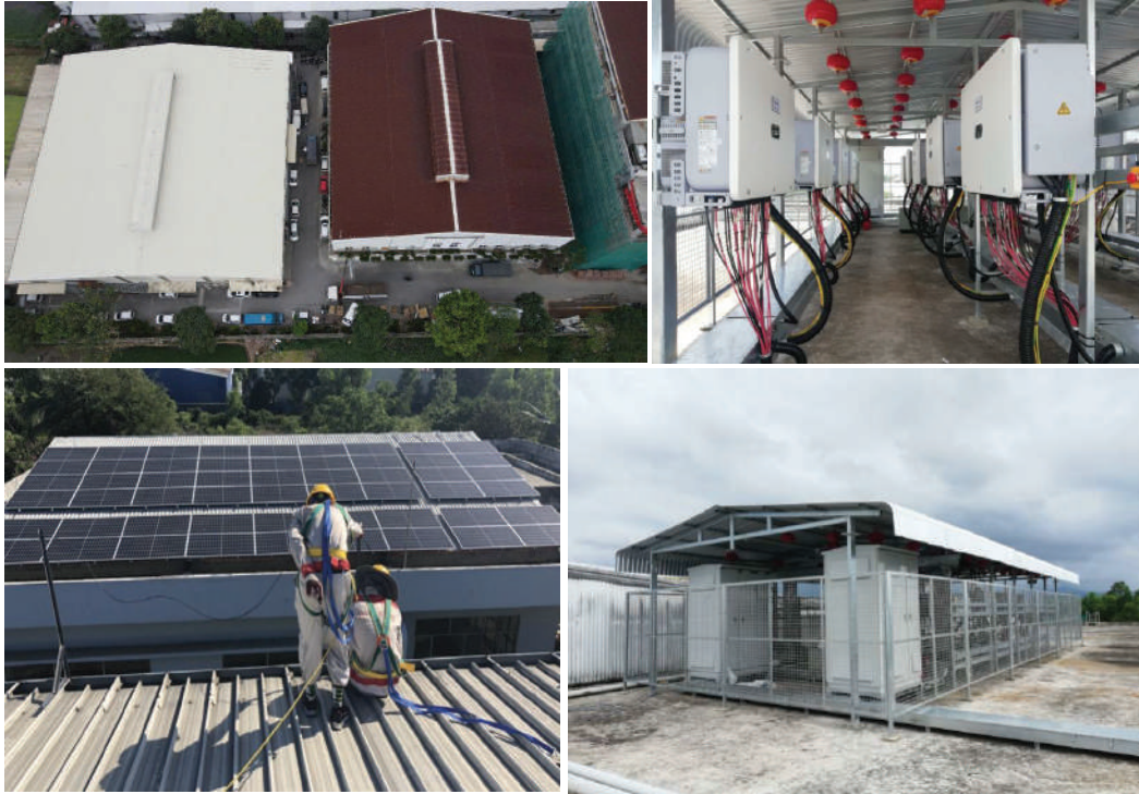
15/ DỰ ÁN: CUNG CẤP LẮP ĐẶT HỆ THỐNG ĐIỆN MẶT TRỜI TỰ SẢN XUẤT TỰ TIÊU THỤ QUY MÔ 1 MWP - CÔNG TY CỔ PHẦN CÔNG NGHỆ THIẾT BỊ TÂN PHÁT
