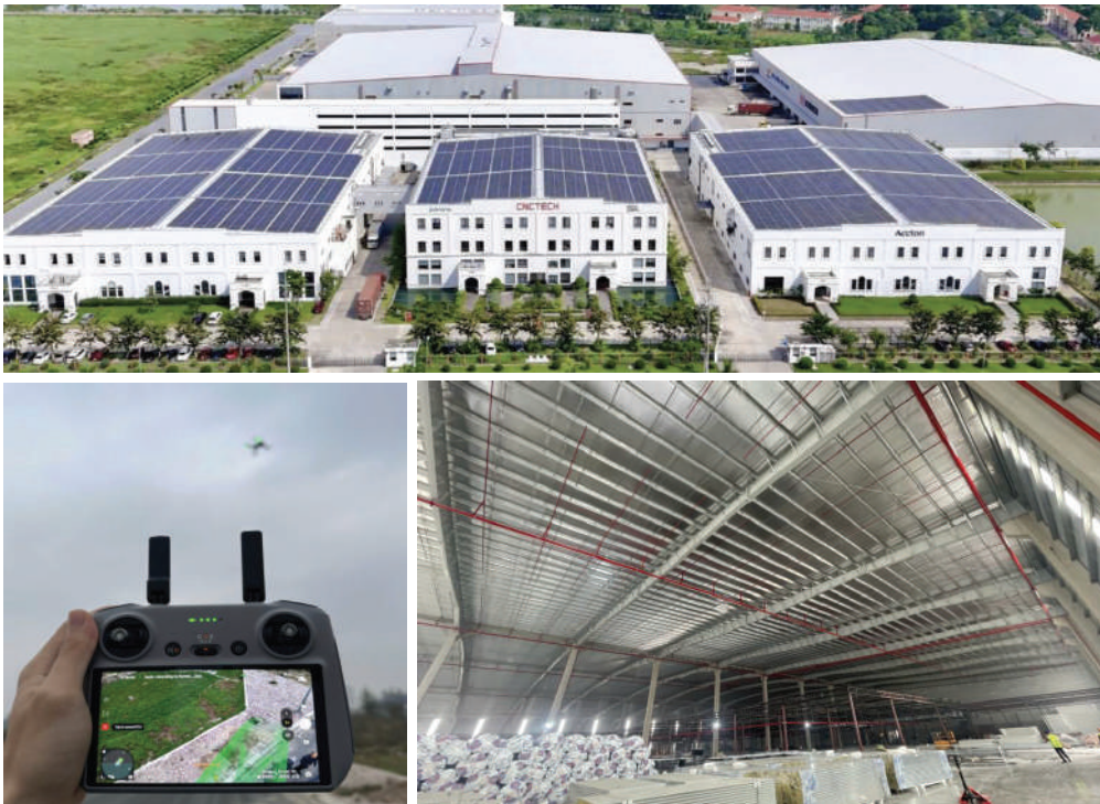
18/ DỰ ÁN: ETEK POWER ĐẦU TƯ BÁN ĐIỆN CHO NHÀ MÁY QUY MÔ 1200 KWP - CNC VĨNH PHÚC
