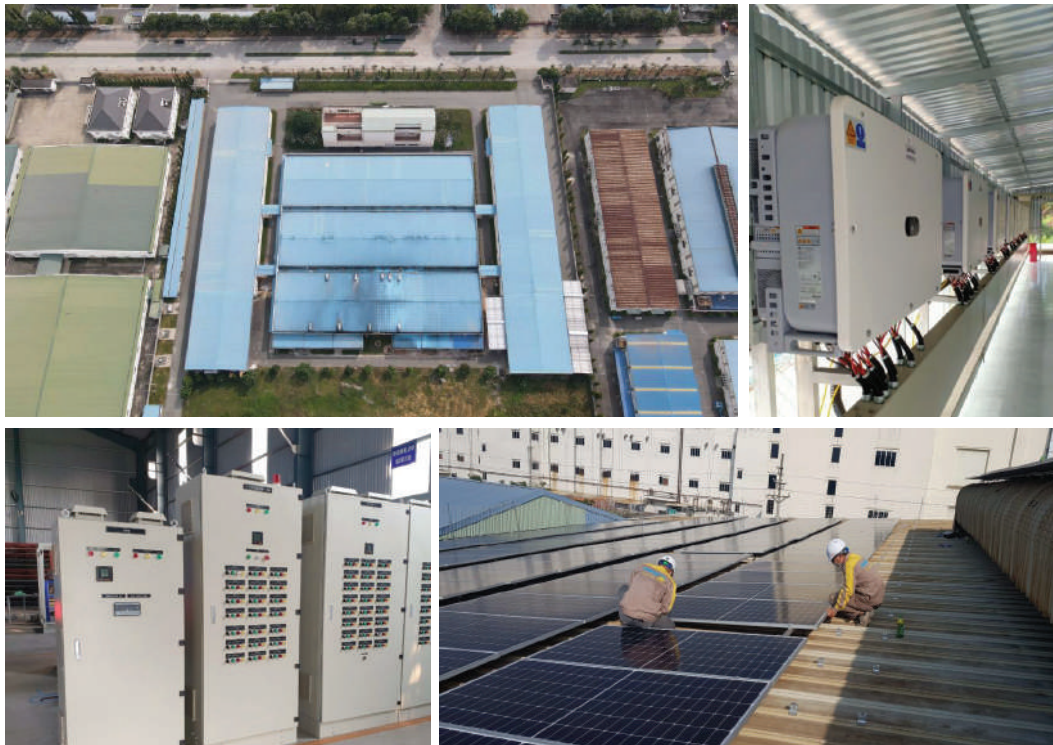
16/ DỰ ÁN: CUNG CẤP LẮP ĐẶT HỆ THỐNG ĐIỆN MẶT TRỜI SẢN XUẤT BÁN ĐIỆN 100% QUY MÔ 2 MWP - CÔNG TY CỔ PHẦN THỰC PHẨM HỮU NGHỊ BÌNH DƯƠNG
