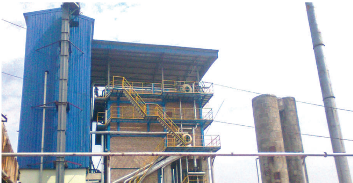
08/ CÔNG TRÌNH THI CÔNG LẮP ĐẶT HỆ THỐNG LÒ HƠI CÔNG SUẤT 20 T/H NHÀ MÁY GIẤY VẠN ĐIỂM – HÀ NỘI
