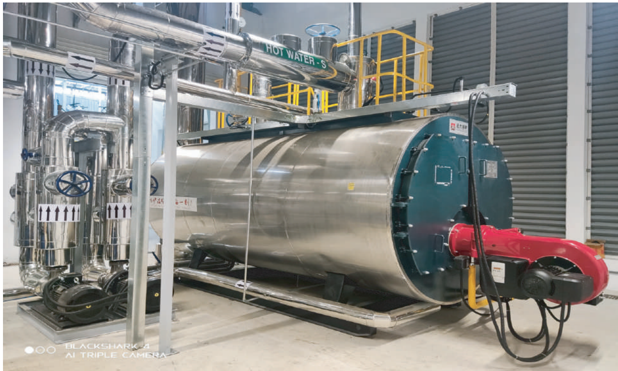
13/ CÔNG TRÌNH THI CÔNG LẮP ĐẶT HỆ THỐNG LÒ NƯỚC NÓNG VÀ ĐƯỜNG ỐNG DẪN NHIỆT CÔNG SUẤT 2.8 MW - NHÀ MÁY VINFAST – HẢI PHÒNG
