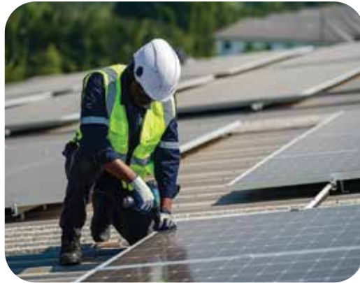
Hệ thống On-grid
