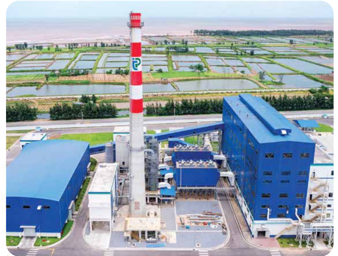
Lò hơi nhiệt công nghiệp
