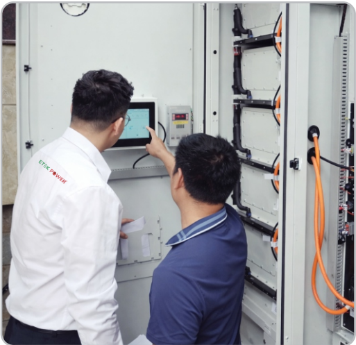
Khách sạn Ninh Bình Công suất: 215 Kwh
